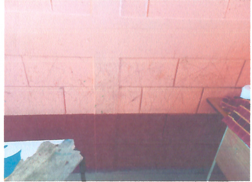
Foto 2: PINTURA EN AULAS, INTERIOR Y EXTERIOR.
