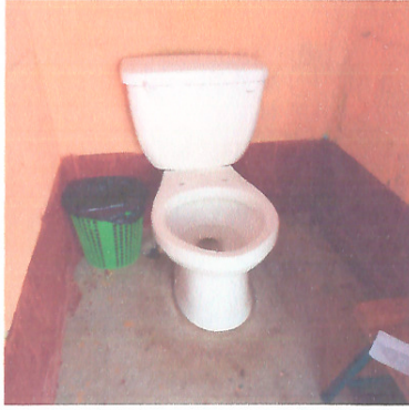
Foto 1: REMODELACION DE SANITARIOS
