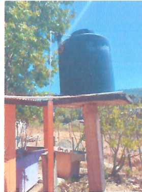
Foto 4: REMODELACION BASE DE TINACO Y CAMBIO DE TUBERIA DE TINACO PARA QUE FUNCIONE.
