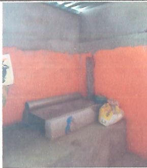
Foto 5: REMODELACION DE COCINA.
