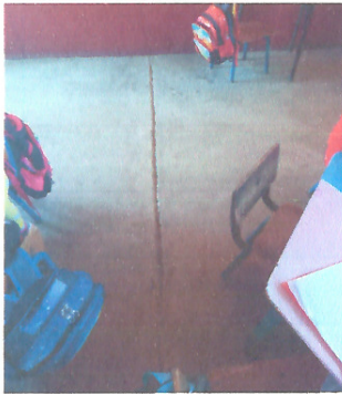
Foto 3: CAMBIO DE PISO EN AULAS.
